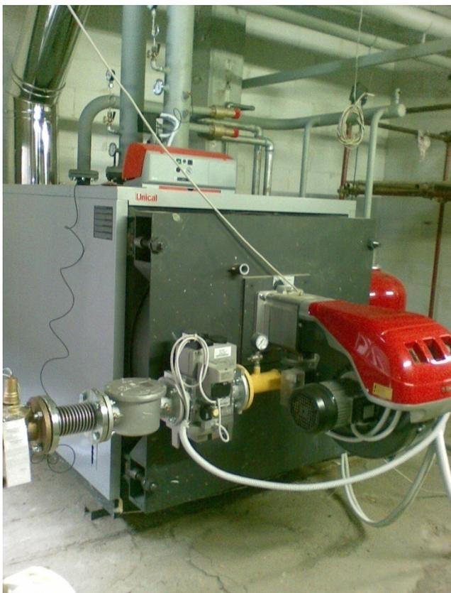
Generatore a metano che produce acqua calda a  $45\div 75^{\circ}\text{C}$ , della tipologia a scorrimento, concepito appositamente per temperature dell'acqua di ritorno molto basse.
