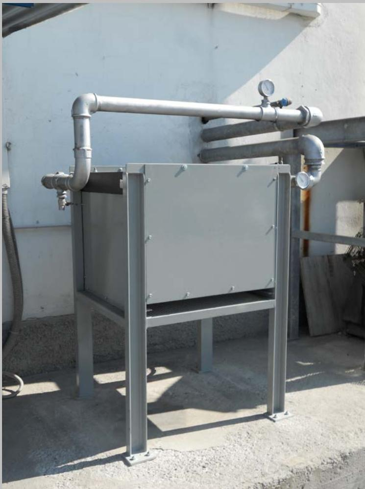
**Foto 2:** Scambiatore provvisorio attualmente installato in sostituzione della torre evaporativa.
