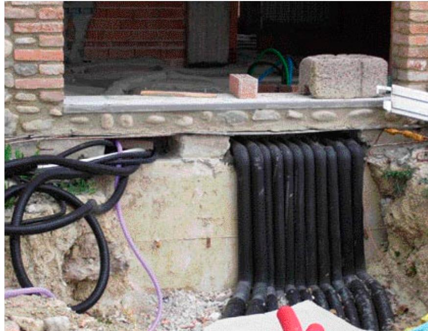
A sinistra il dettaglio dell'uscita delle tubazioni della centrale tecnologica, a destra l'ingresso al fabbricato A per le tubazioni dell'impianto di climatizzazione e gli impianti sanitari
